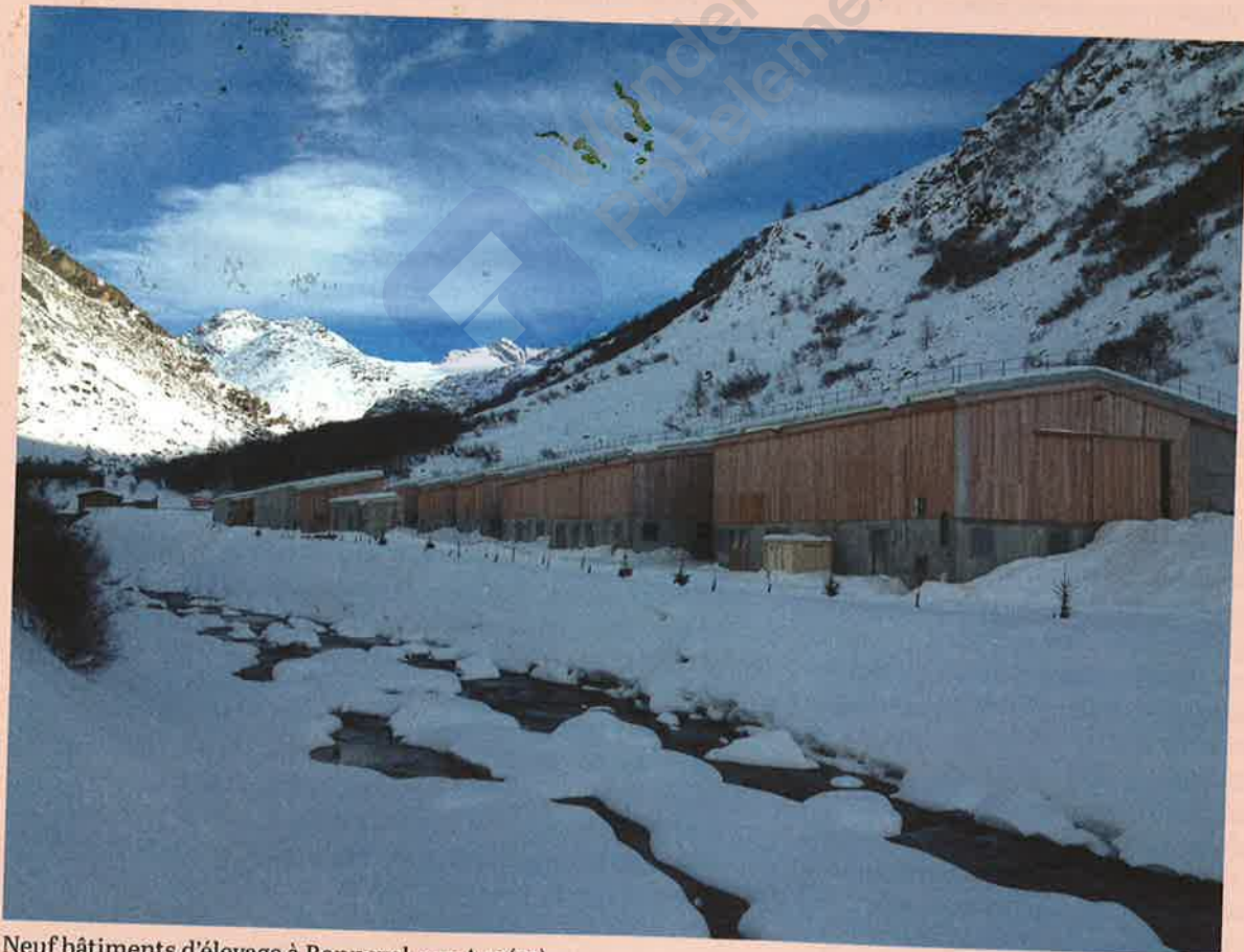
Neuf bâtiments d'élevage à Bonneval-sur-Arc (73). Architecte et paysagiste mandataire: FABRIQUES. Première tranche livrée en octobre 2013. © Pierre Janin
